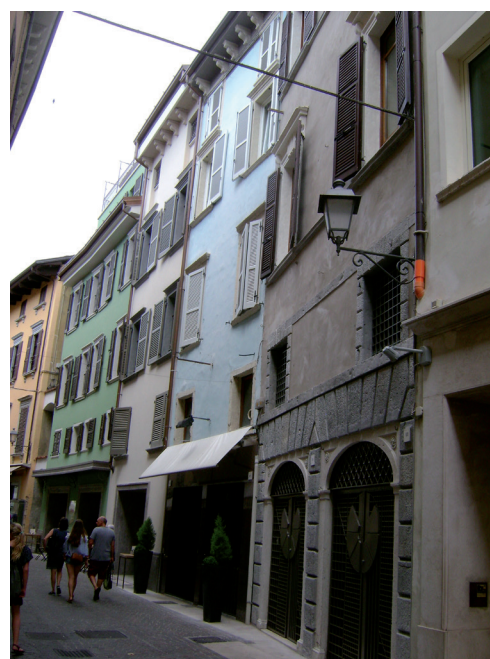
Fig. 1 Tipiche case salodiane: al piano terra la bottega, all'amezzato il laboratorio, ai livelli superiori il piano "nobile" e il dormitorio della servitù (foto di Giovanni Pelizzari).
