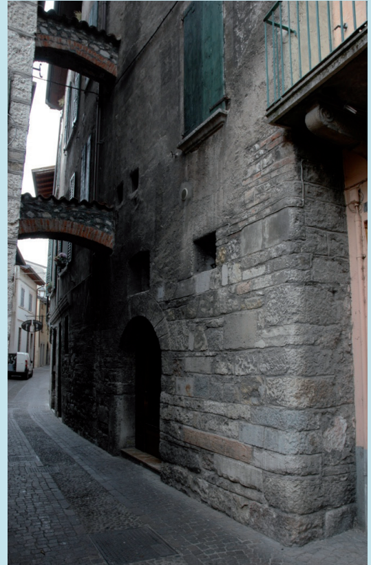
Fig. 37. Salò, edificio medievale in via di Mezzo.
