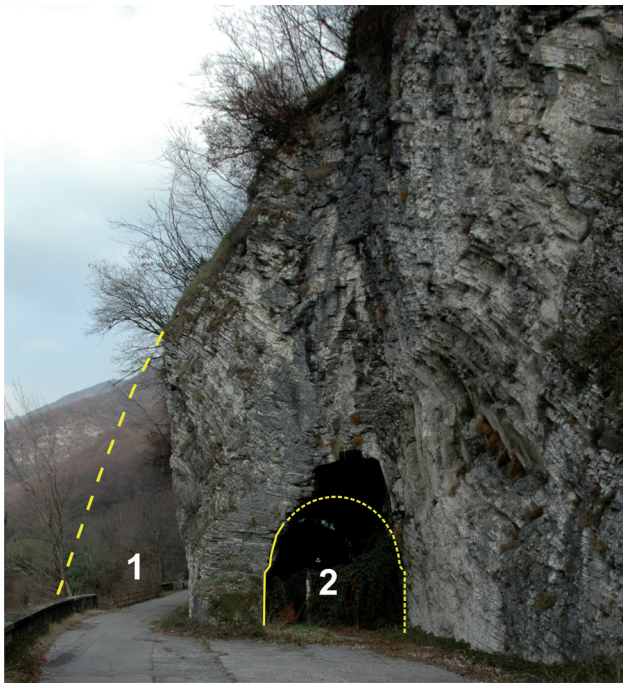
Fig. 22. Vobarno, la vecchia galleria, probabile “via cava” con il profilo originario della montagna (1) e della volta (2), modificati in età moderna.
