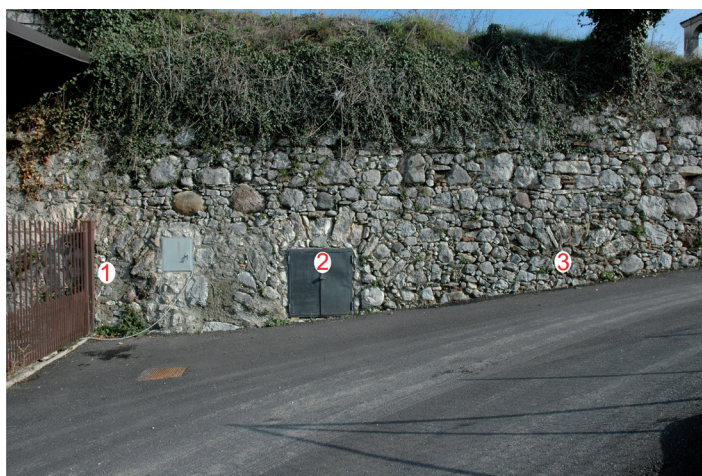
Fig. 16. Arcate nel muro di sostruzione della strada presso il ponte "Camera".
